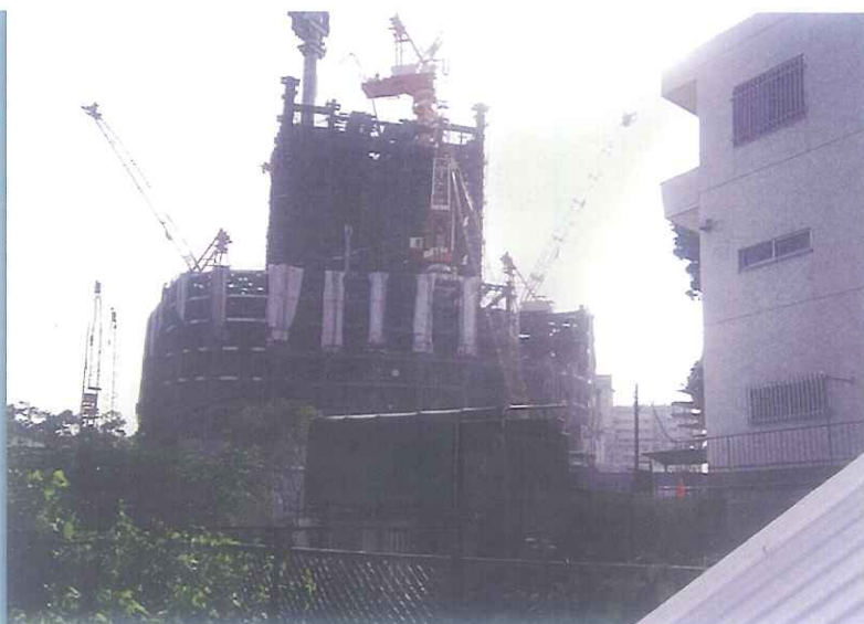
H13 年 3 月 六本木ヒルズビル初期工事
