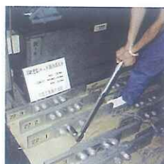
すべり試験 (本締仮締状況)
