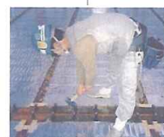
現場作業でのハンマー試験
