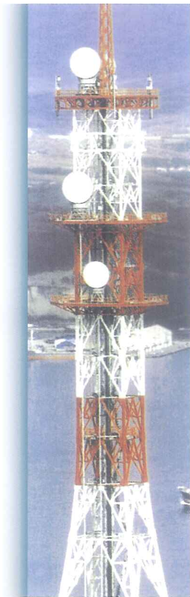
鉄塔・高力ボルト
