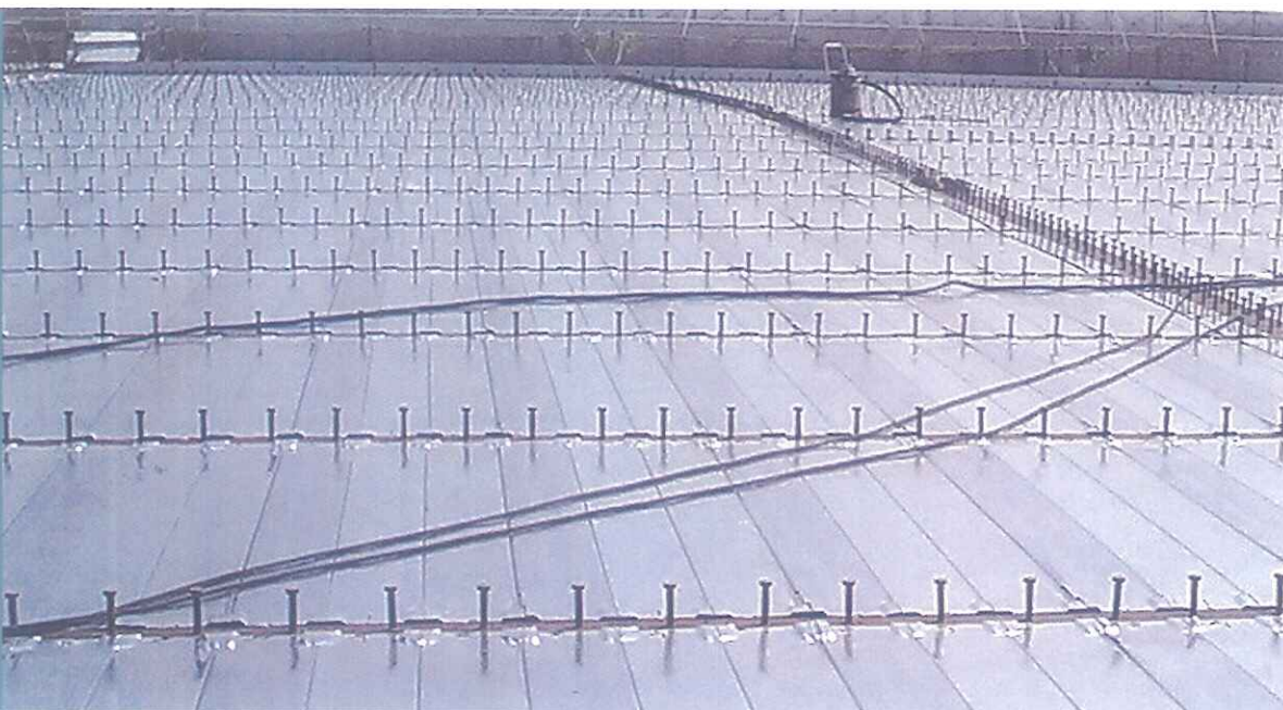
H22 年 1 月 八尾市徳州会病院棟
