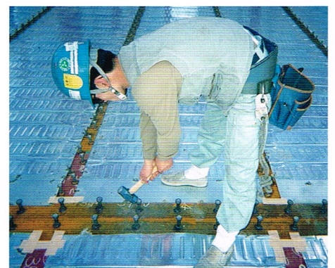
現場作業でのハンマー試験
